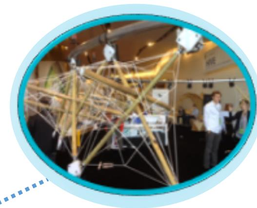
La eficiencia del tensegrity depende de la utilización de poco material y por lo tanto lograr estructuras de bajo peso.
