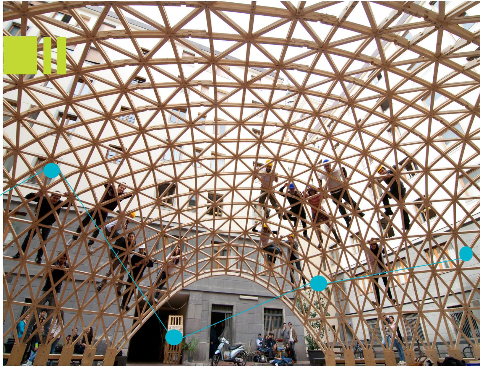
Las CONCHAS son estructuras simples o doblemente curvadas que resisten cargas impuestas a través del estrés de la membrana en el plano. Como funciona como un caparazón, estas estructuras son capaces de tener valores relativamente altos de resistencia al peso mientras logra cubrir tramos largos.
